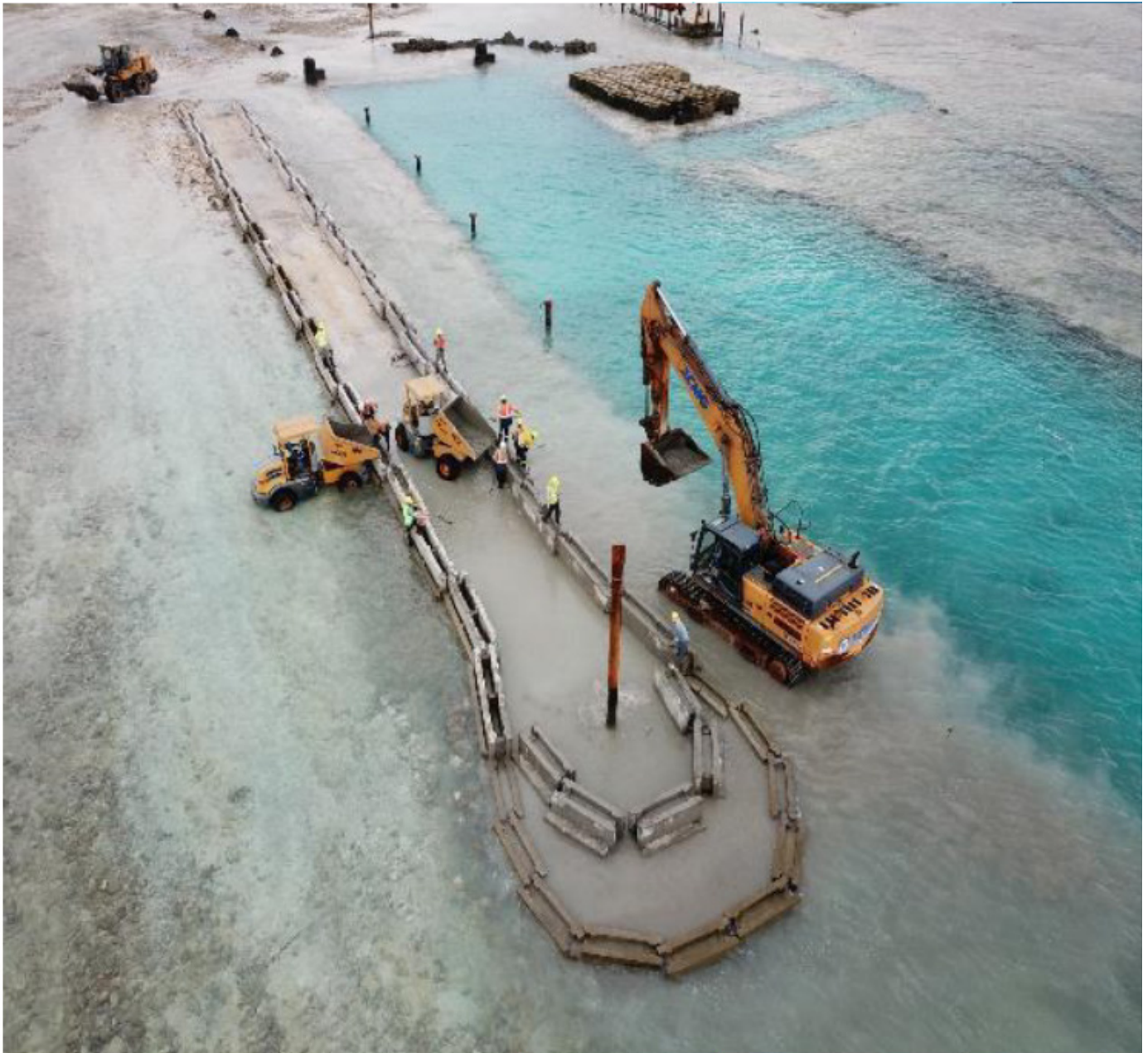
Figure 13: Exemples de travaux à marée basse et d'endiguement à Nukulaelae, Tuvalu.
