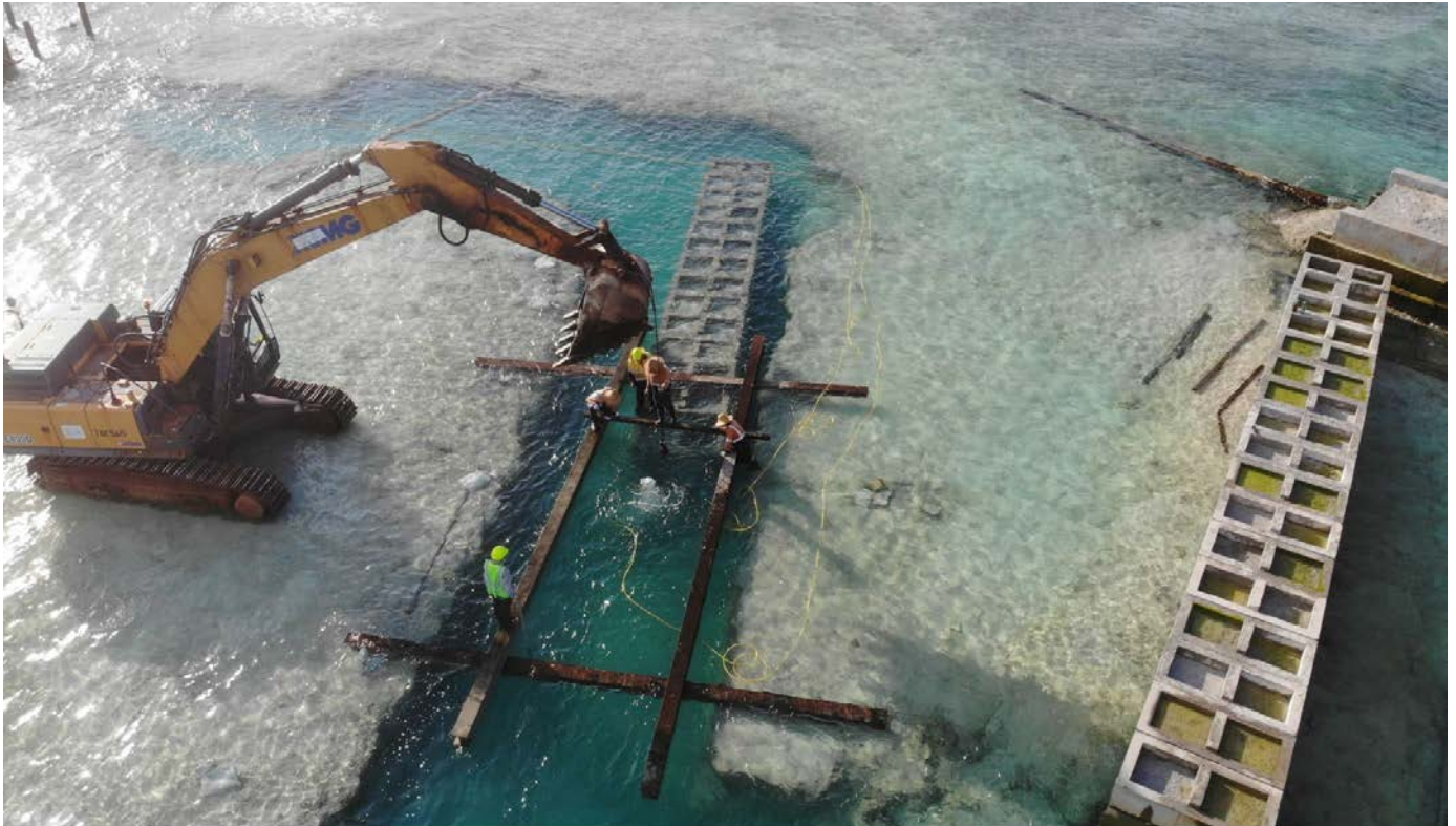
Figure 15: Utilisation de couloirs de travail et de zones de confinement à Nukulaelae, Tuvalu
