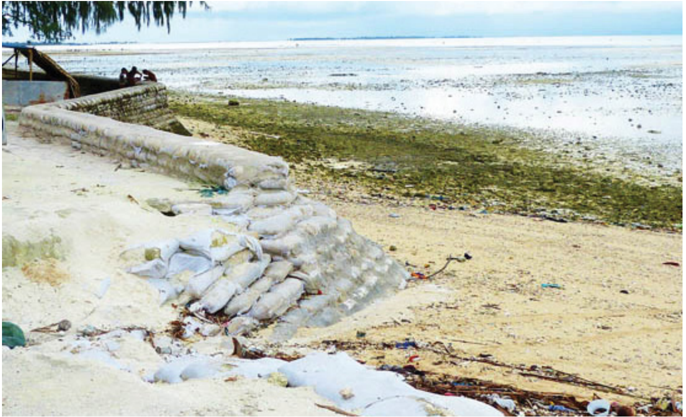
Figure 6: Une digue en dur à Tarawa, Kiribati (PROE 2015)
