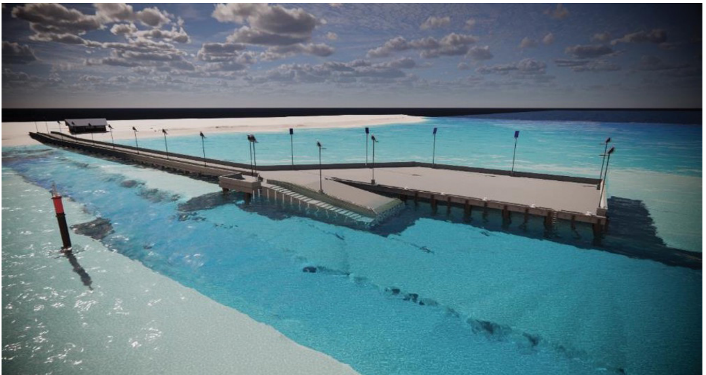
Figure 1: Exemple de quai et nouveau poste d'amarrage dragué, adjacent à la rampe de mise à l'eau existante
