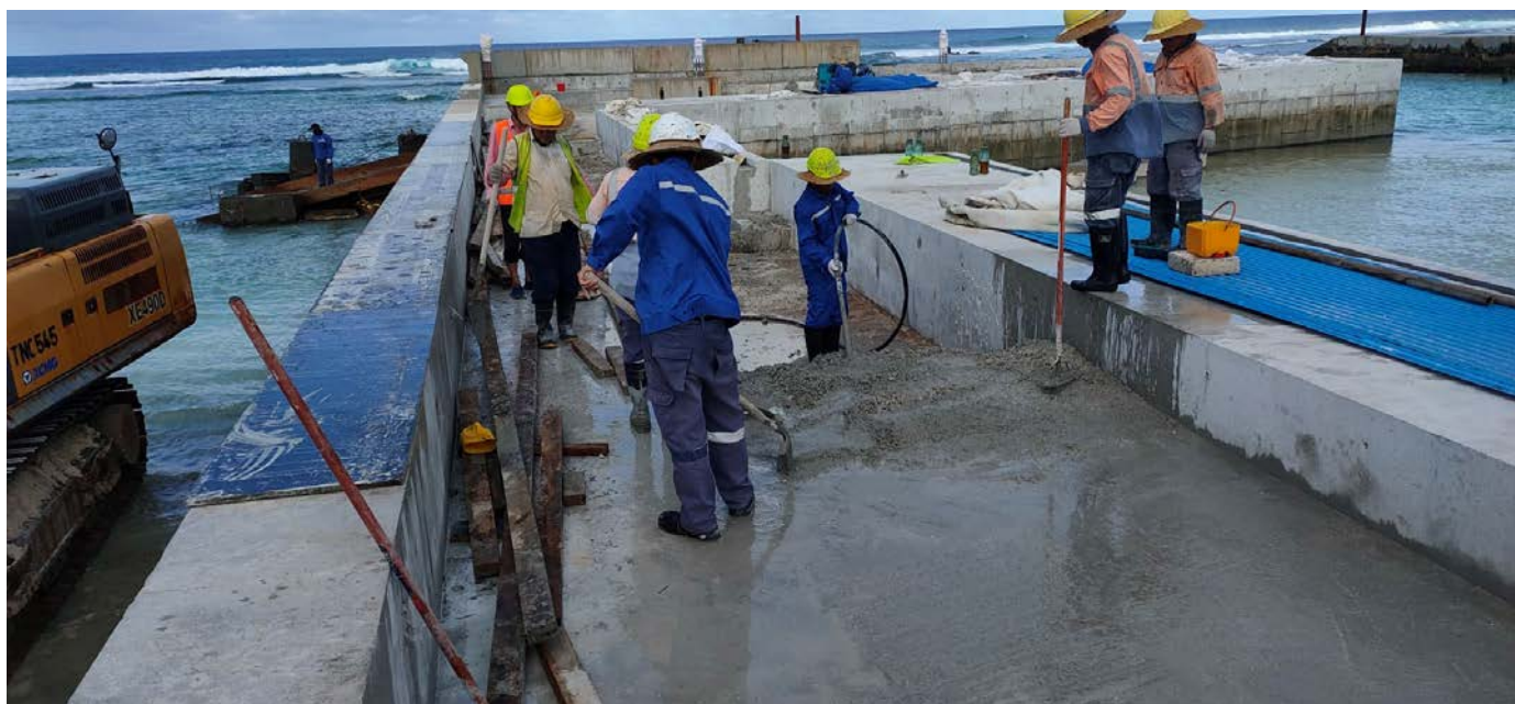
Figure 12: Exemples de travaux à marée basse et d'endiguement à Nukulaelae, Tuvalu.
