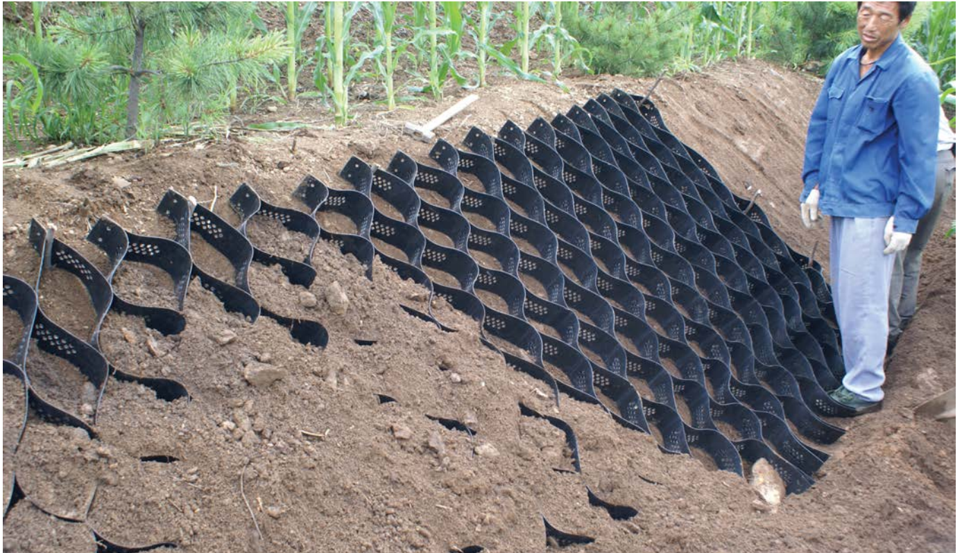
Figure 8: Matrice géotextile utilisée pour stabiliser les pentes (Source : https://www.okorder.com/p/hdpe-geocell-with-ce-certificate-for-road-construction_1031785.html )
